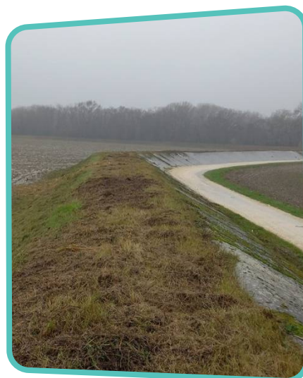
Ouvrage de Surelle après entretien
