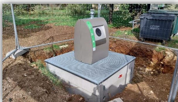
Conteneur enterré pour la collecte du verre à Suze la Rousse.
