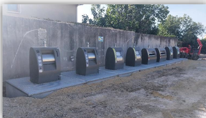
Travaux Suze La Rousse
