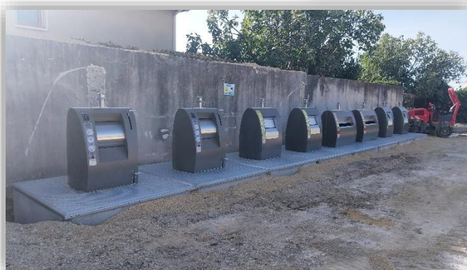
Travaux Suze La Rousse
